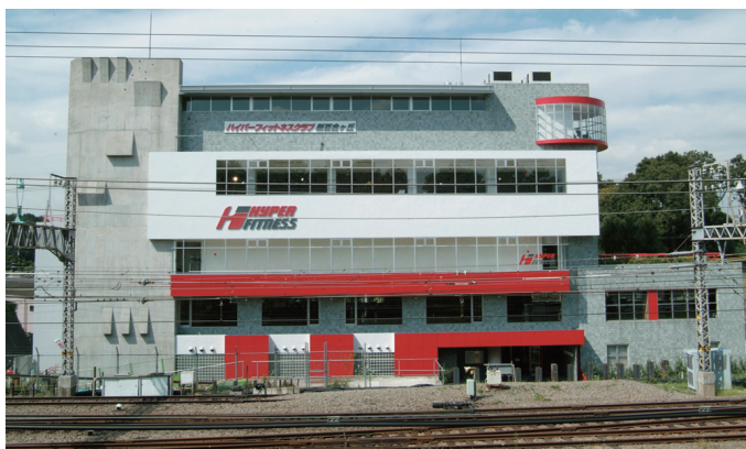
小田急線の線路側から見た外観
