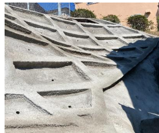
急傾斜地崩壊対策工事 (川崎市麻生区)
