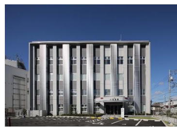
緑警察署新築工事
